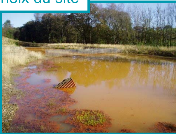
Bassin de décantation
